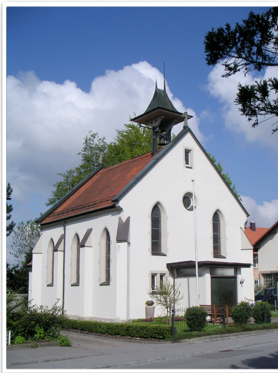
Christuskirche Vogt, erbaut 1901, renoviert 2001
